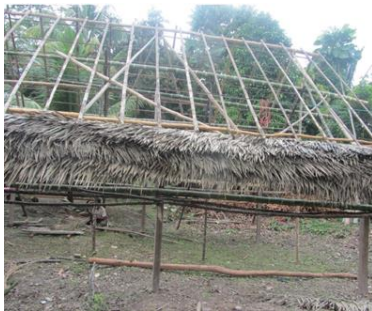
Figura 1. Estado inicial de la vivienda de la investigación
